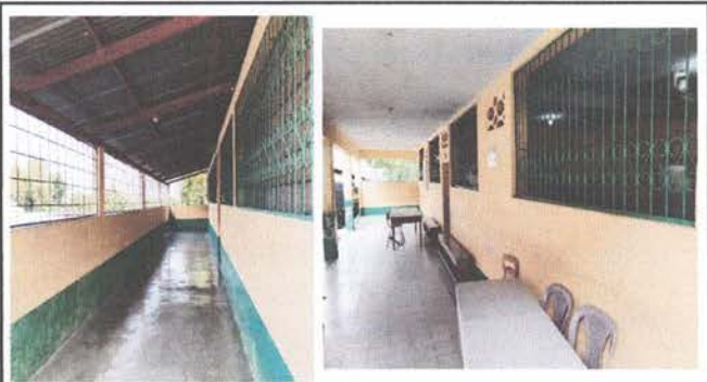
4.2 MANTENIMIENTO A BALCONES
