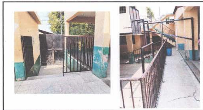
4.3 MANTENIMIENTO A BARANDAS
