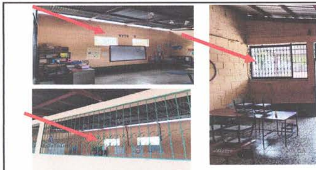
2.3 FABRICACIÓN E INSTALACIÓN DE VENTANAS PVC
