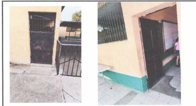
4.1 MANTENIMIENTO A PUERTAS
