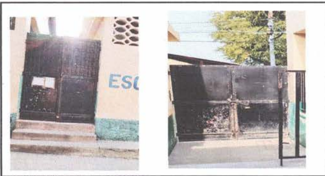
4.4 MANTENIMIENTO A PORTÓN
