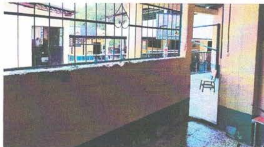
1.1 FABRICACIÓN E INSTALACIÓN DE PUERTA
