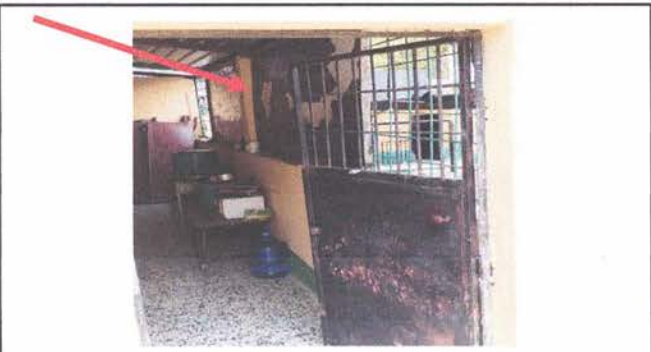
3.1 FABRICACIÓN E INSTALACIÓN DE MOSQUITERO
