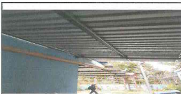
Foto 5: MANTENIMIENTO A BAJADAS AGUAS PLUVIALES Y TECHADO
