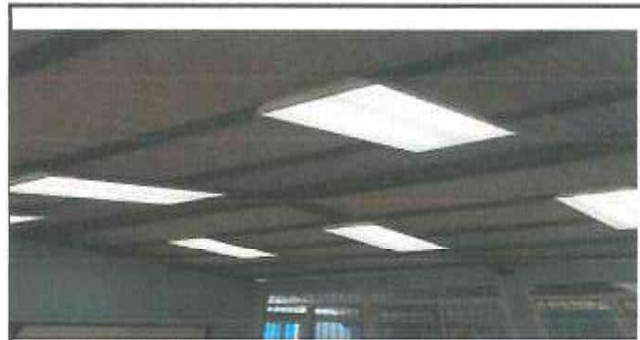
Foto 4: REPARACION DE SISTEMA ELECTRICO
