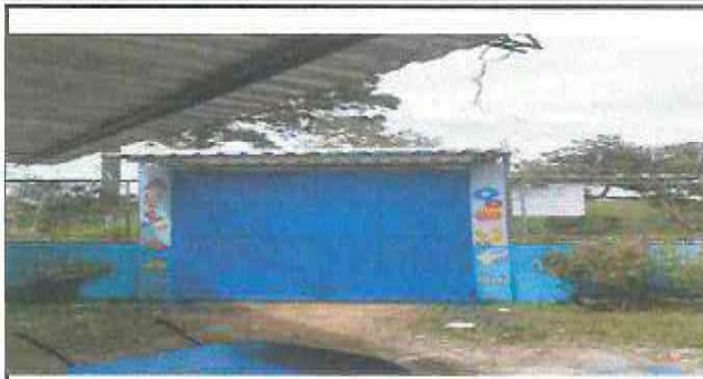
Foto 1: PORTON DE ENTRADA PRINCIPAL
