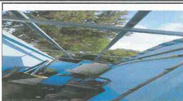
Foto 2: REPARACION DE BAJADAS DE AGUA PLUVIALES
