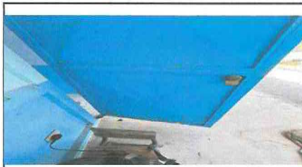
Foto 4: MANTENIMIENTO DE PUERTA DE AULA
