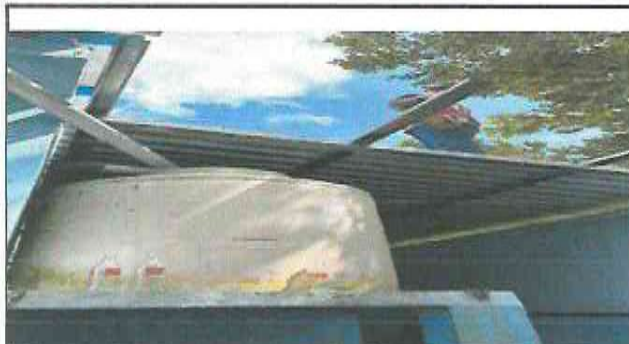
Foto 3: TECHADO EN BAJADAS DE AGUAS PLUVIALES A ROTOPLAST
