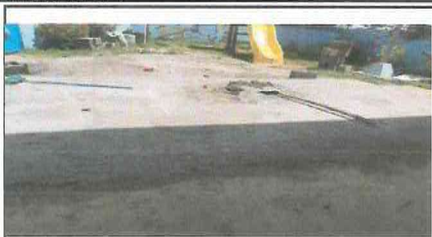
Foto 1: SUSTITUCION DE PISO DE CONCRETO PARTE DE ENFRETE DE LA ESCUELA
