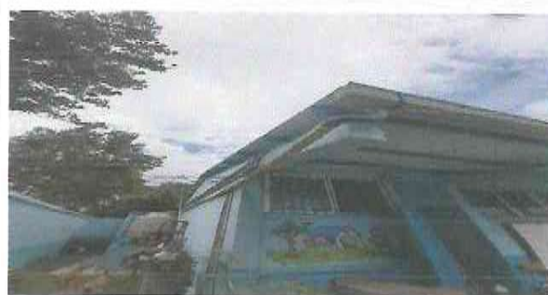
Foto 4: PINTURA EN MUROS Y REPARACION DE BAJADA DE AGUAS PLUVIALES
