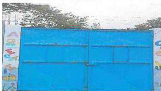
Foto 5: MANTENIMIENTO A PORTON
