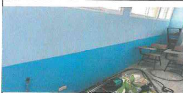
Foto 6: PINTURA EN MUROS INTERIORES
