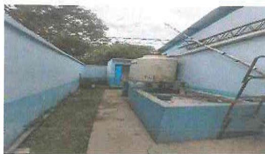
Foto 2: REPARACION DE BAJADAS DE AGUA PLUVIALES
