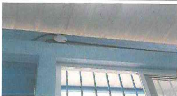
Foto 3: PINTURA EN MUROS
