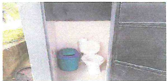
Foto 6: Baños. Sustitución de azulejo
