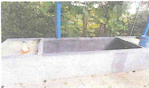
Foto 5: Baños. Sustitución de pila de cemento
