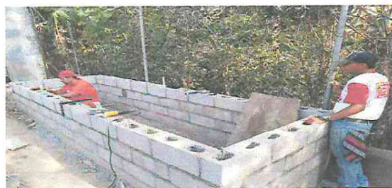
Foto 5: Baños. Sustitución de pila de cemento
