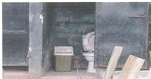
Foto 6: Baños. Sustitución de azulejo
