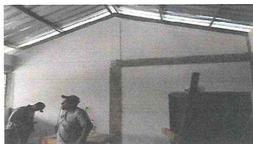
Foto 4: Aulas. Sustitución de cernido
