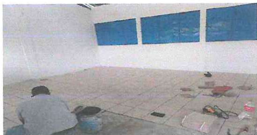
Foto1: Aulas. Sumunistro e instalación de piso cerámico en aulas.
