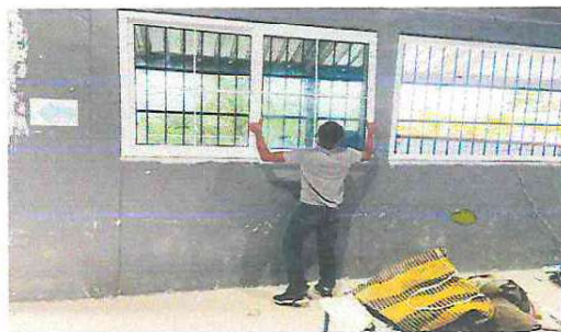
Foto 2: Aulas. Instalación de ventanas PVC
