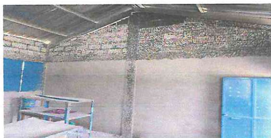
Foto 3: Aulas. Sustitución de repello.
