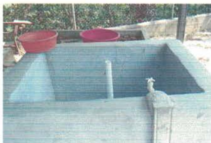
Foto 5:Baños Sustitución de pila de cemento
