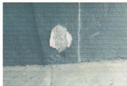
Foto 4:Aulas. Sustitución de cernido
