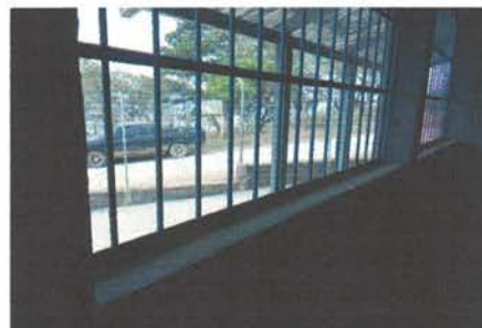
Foto 2: Aulas. Instalación de ventanas PVC
