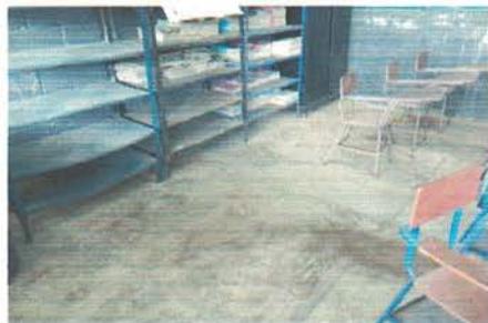
Foto1: Aulas. Suministro e instalación de piso cerámico en aulas
