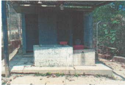
Foto7: Baños Sustitución de piso de cerámico
