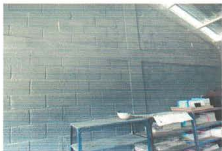
Foto 3:Aulas. Sustitución de repello
