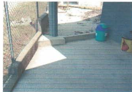
Foto 12: Cocina. Instalación de piso cerámico
