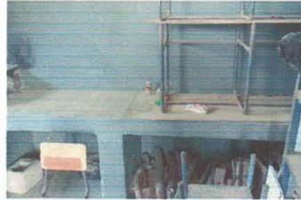
Foto 10: Cocina Instalación de piso cerámico
