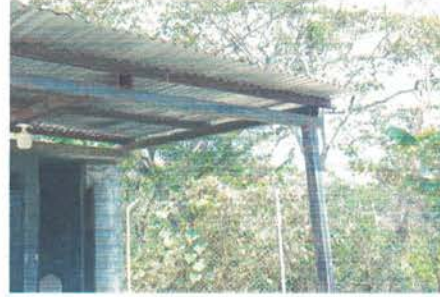
Foto8: Baño Instalación de lámina troquelada calibre 26
