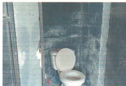
Foto 6: Baños Sustitución de azulejo
