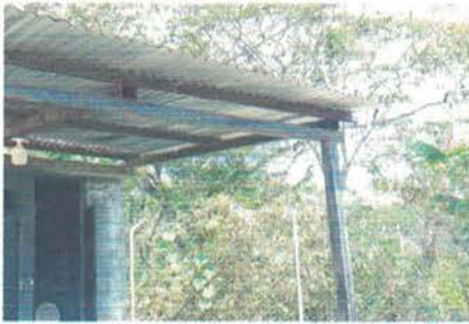
Foto 9: Baño Instalación de estructura de soporte de metal (incluyendo columnas de metal).
