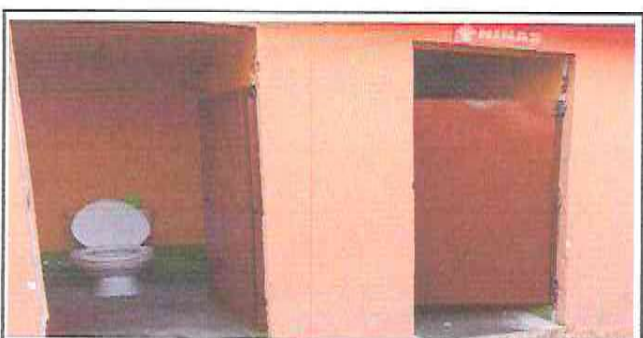
Foto 5: Instalación de baños y puertas
