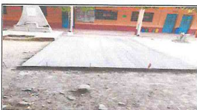
Foto 4: Realización de la plancha de cemento
