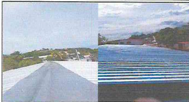
Foto 1: Tejado de galera
