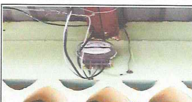
Foto 6: Instalación nueva del suministro eléctrico
