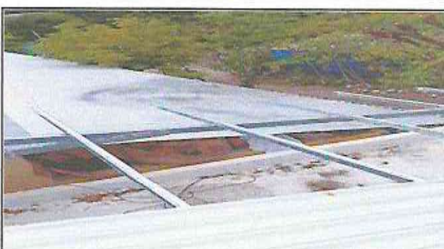
Foto 4: Ensamblando las láminas troqueladas.
