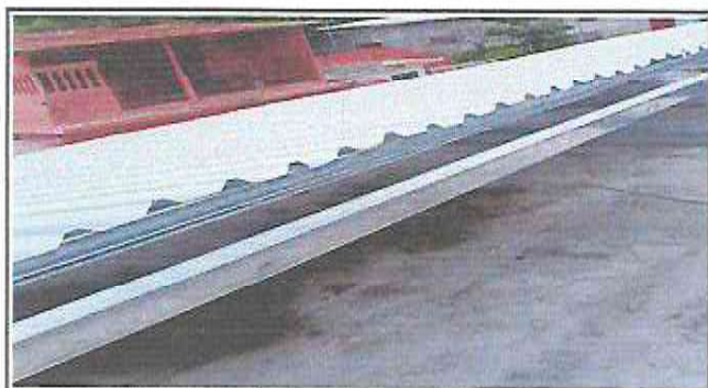
Foto 3: Instalación de lamina troquelada
