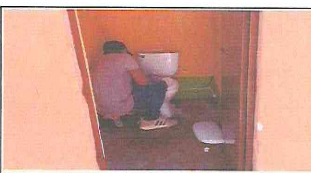
Foto 6: Instalacion de sanitarios
