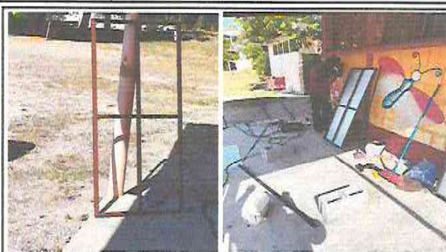
Foto 2: Soldadura y pintura de las puertas de los baños.
