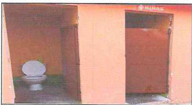
Foto 5: Instalando las puertas de los baños
