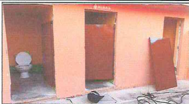
Foto 1: Reparación de puertas de los baños
