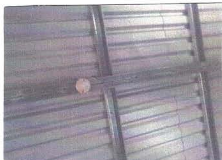
Foto 13 : Sustitución de lamparas
