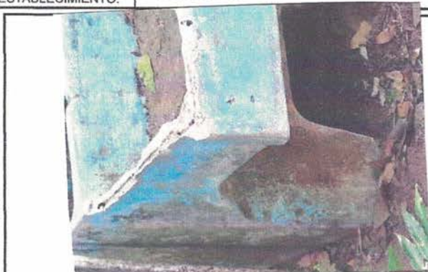
Foto 18 : Sustitución de pila plastica de dos lavaderos
