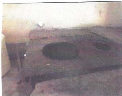
Foto 16: Sustitución de plancha de metal de 3 hornillas
