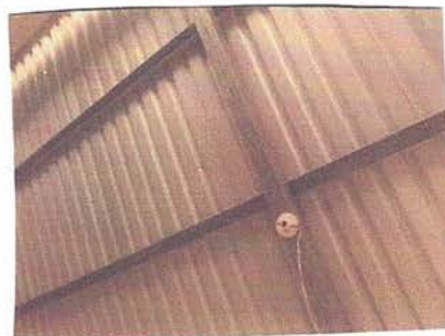
Foto 14 : Sustitución de plafoneras
