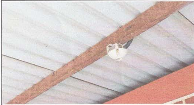
Foto 1: Sustitución de luminarias
