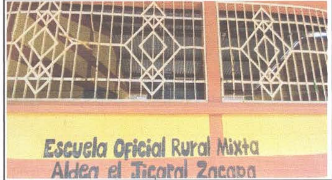
Foto 4: Instalación de ventanas
