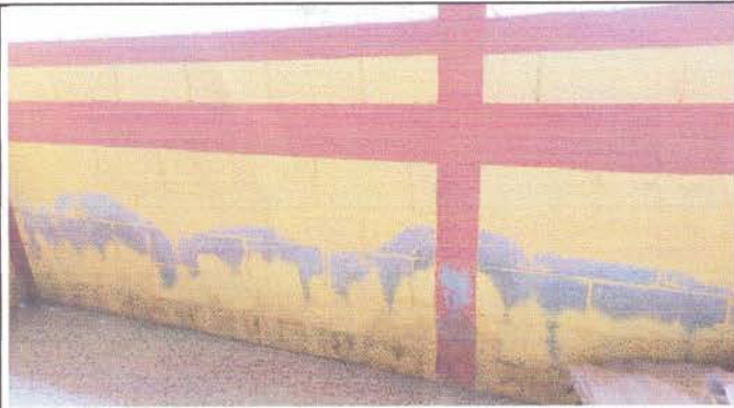
Foto 1: Impermeabilizar muros con impermeabilizante
