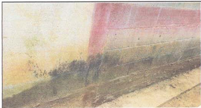
Foto 5: Repello en muros.
