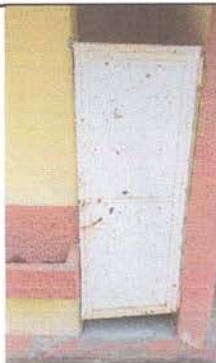
Foto 5: Mantenimiento de puerta, reparación, lijado y pintura.
