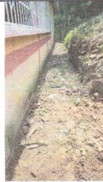
Foto 2: Sustitución de planchas de concreto
