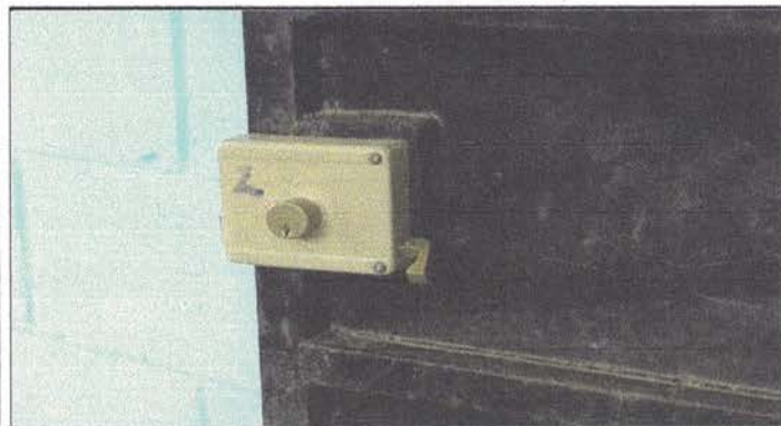
Fotografía 3. Sustitución de chapa en puerta.
