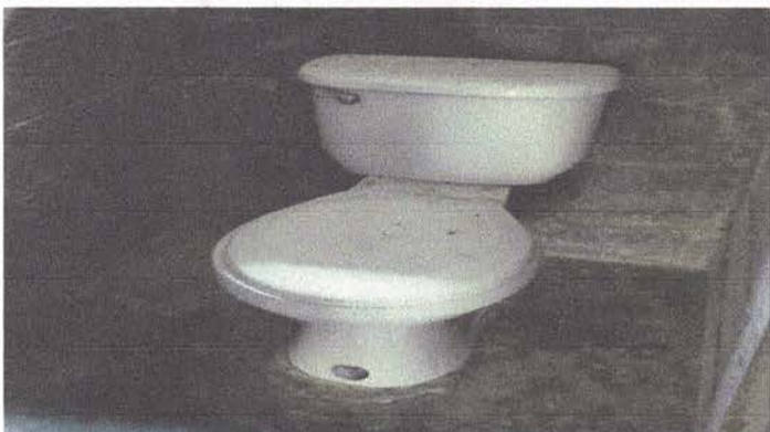
Fotografía 9. Sustrucción de inodoro e instalación de piso cerámico.
