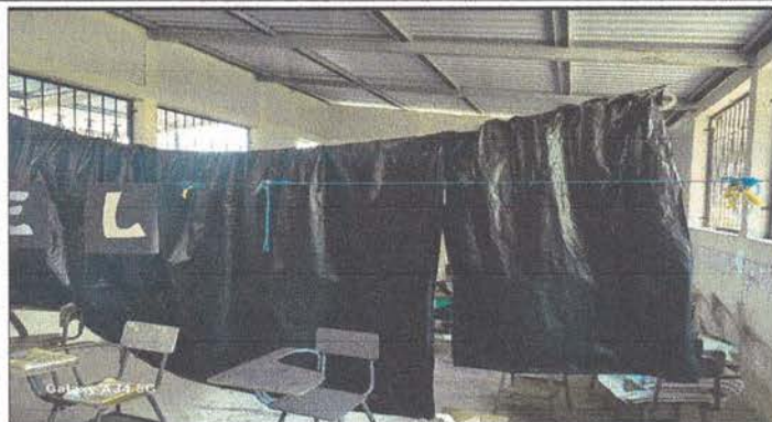
Fotografía 1. Instalación de muro.
