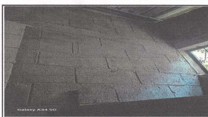
Fotografía 10. Pintura de muros exteriores e interiores.
