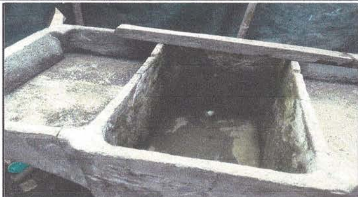
Fotografía 7. Sustrucción de pila de concreto.
