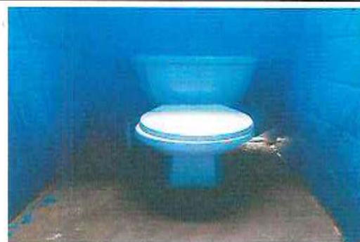
Foto 4: Finalización de trabajos de sustitución de inodoro, accesorios e instalaciones.
