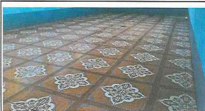
Foto 3: Finalización de colocación de piso cerámico.
