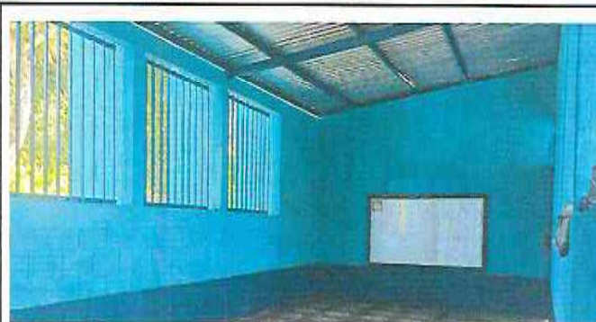
Foto 2: Pintura en muros interiores y exteriores.
