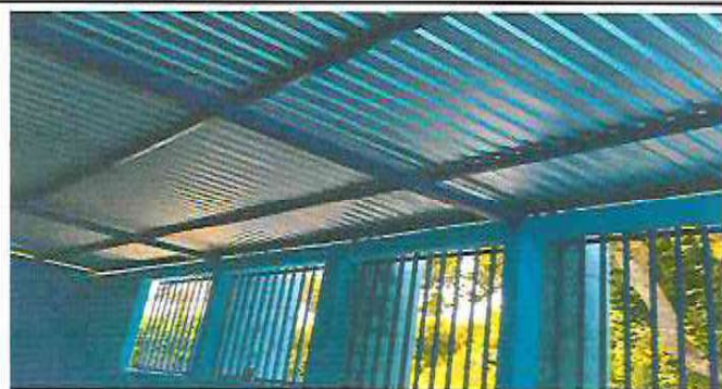
Foto 1: Finalización de cambio de cubierta de lámina troquelada.
