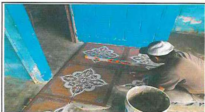
Foto 3: Colación de piso cerámico.
