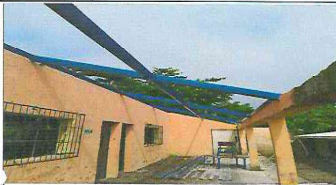
Foto 1: Momento durante el cual se trabaja para colocar la lámina troquelada.
