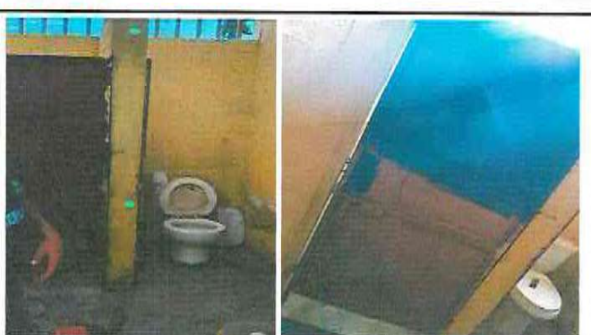
Foto 4: Colocación y remodelación de espacio para inodoro.
