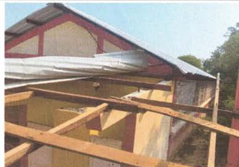
Foto 2: Sustrucción de estructura de soporte de metal
