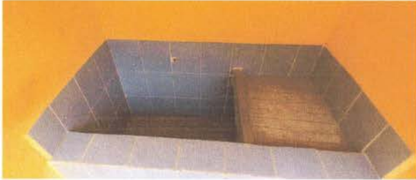
Foto 7: Tapadera de metal para pila
