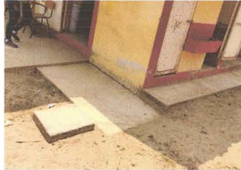
Foto 8: Remozamiento de fosa séptica
