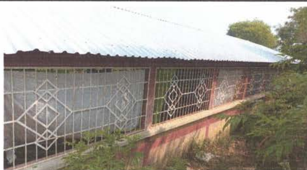
Foto 3: Instalación de canal de metal
