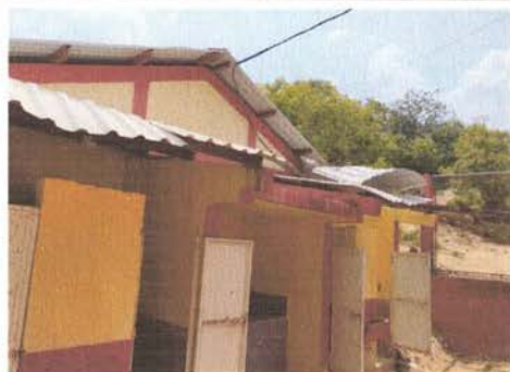
Foto 1: Sustrucción de lámina troquelada
