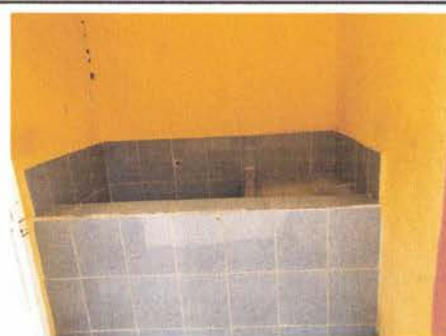
Foto 6: Sustrucción o instalación de azulejos en pila.
