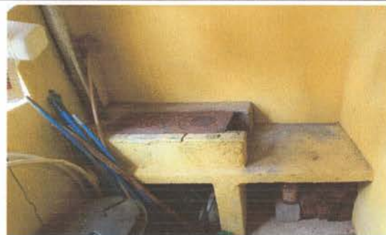
Foto 12: Sustitución de mueble de concreto.
