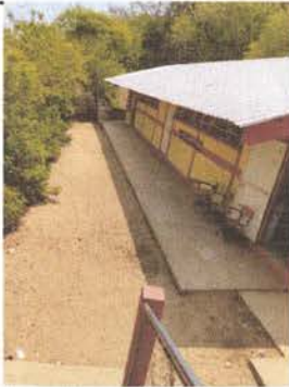
Foto 9: Instalación de planchas de concreto.
