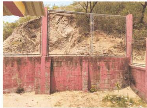
Foto 10: Sustitución o instalación de muros.
