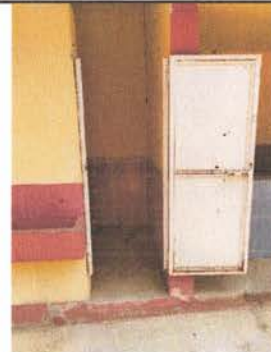
Foto 4: Sustrucción de inodoro.
