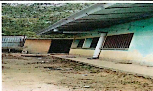
PINTURA DE MUROS EXTERIORES E INTERIORES
