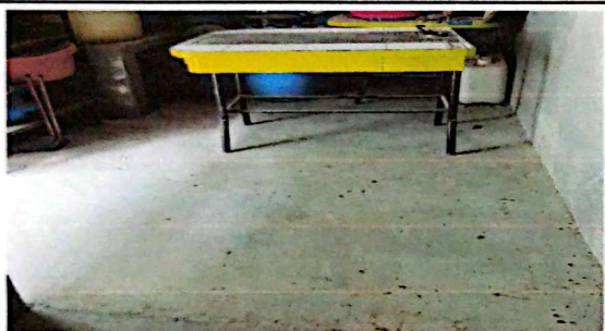
SUSTITUCIÓN DE PISO DE CEMENTO A PISO DE GRANITO EN COCINA
