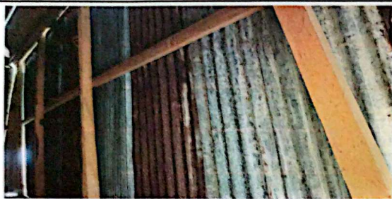
SUSTITUCIÓN DE LAMINA, POR LÁMINA TROQUELADA ALUZINC CALIBRE 26, SUSTITUCIÓN DE ESTRUCTURA DE SOPORTE DE MADERA, POR METAL
