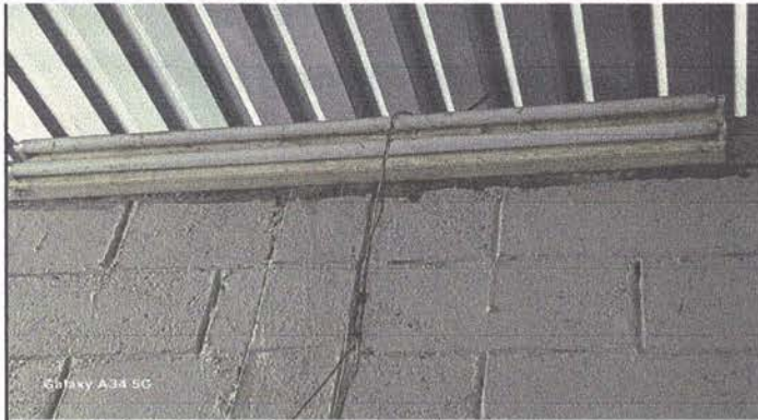
Fotografía 1. Sustitución de lamparas por bombillas.
