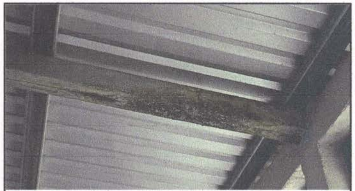
Fotografía 4. Mantenimiento de estructura de soporte.
