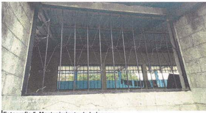
Fotografía 5. Mantenimiento de balcones.
