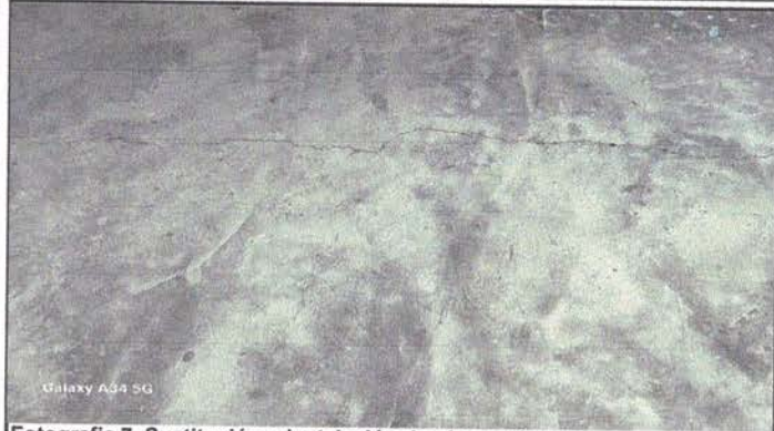
Fotografía 7. Sustitución o instalación de pizo cerámico
