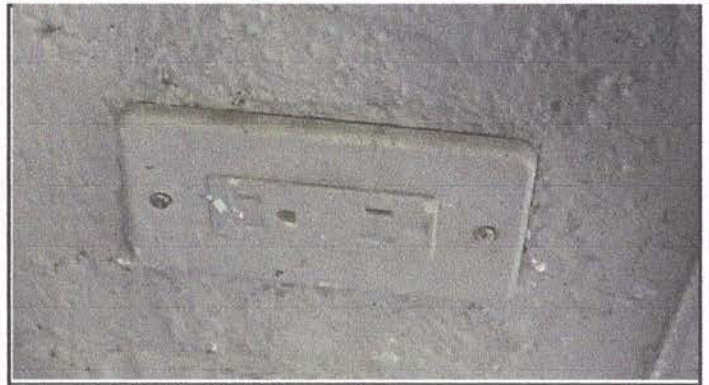
Fotografía 2. Sustitución de tomacorrientes.
