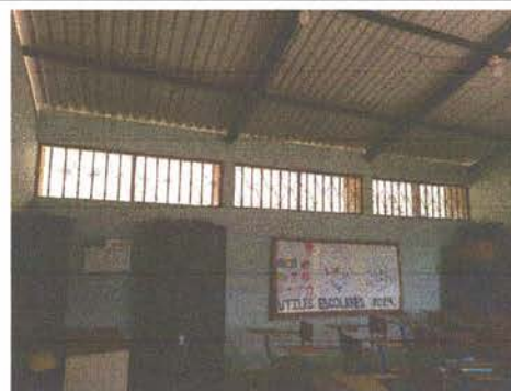
Foto 2: Sustrucción de Estructura de soporte de metal.
