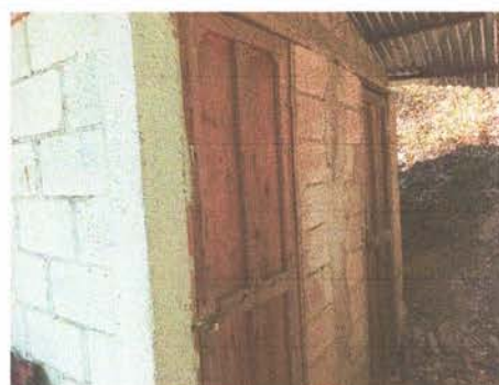
Foto 4: Sustrucción de Puerta de servicios sanitarios
