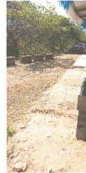
Foto 8: Sustitución de Piso de concreto
