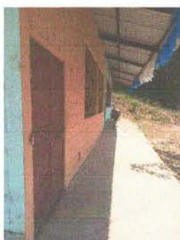
Foto 3: Sustrucción de puertas
