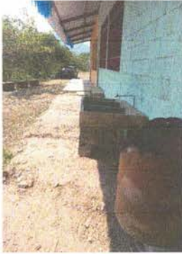
Foto 7: Reparación de banquetas de concreto
