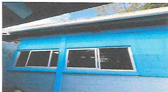
CERRAMIENTO DE VANO, INSTALACIÓN DE VENTANAS PVC E INSTALACIÓN DE CANALES DE PVC
