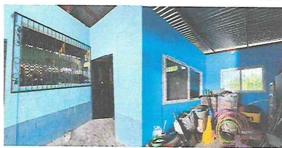
PINTURA EN MUROS Y BALCONES TERMINADA E INSTALACIÓN DE VENTANAS DE PVC
