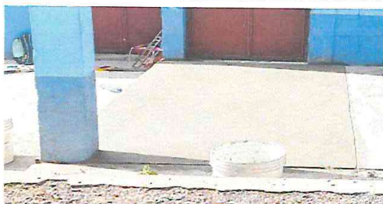
PISO LIQUIDO TERMINADO
