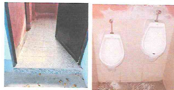
PISO Y AZULEJO EN MINGITORIO TERMINADO
