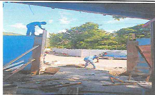
REPARANDO COLUMNAS DE MURO PERIMETRAL
