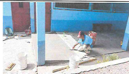
SUSTITUYENDO PISO DE CEMENTO LÍQUIDO
