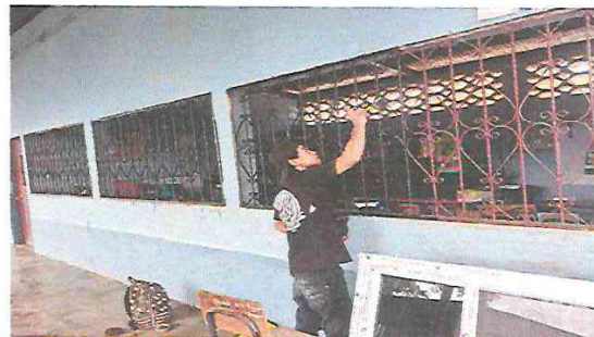
PINTANDO MUROS Y BALCONES
