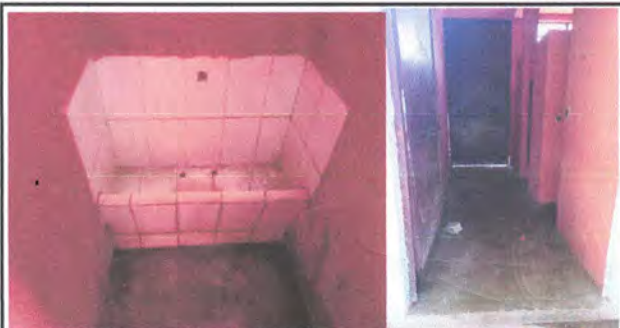
AREA DE BAÑOS: SUSTITUCIÓN A MINGITORIO DE LOSA / SUSTITUCIÓN DE PISO DE CONCRETO A PISO CERÁMICO Y AZULEJO EN PAREDES
