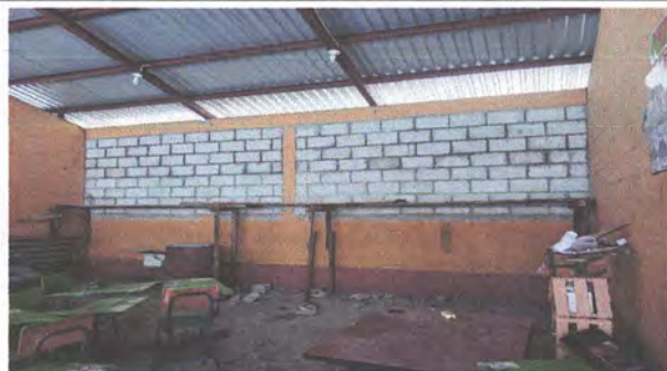
AREA DE EXTERIORES: PINTURA EN MUROS
