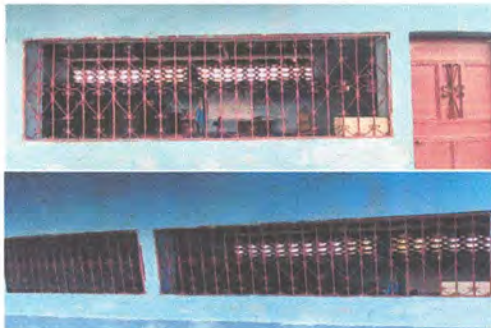
AULAS: MANTENIMIENTO A BALCONES DE METAL
