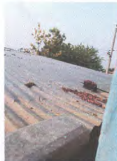
BODEGA: SUSTITUCION DE CANAL DE METAL A CANAL PVC
