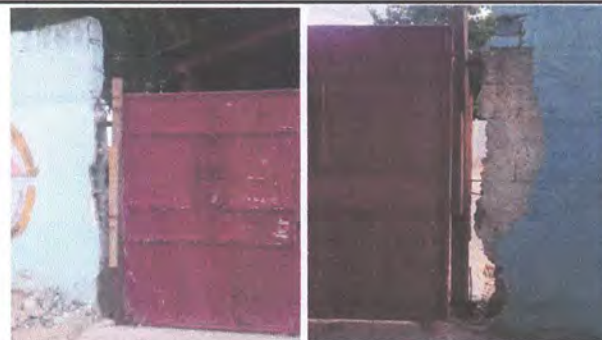
AREA DE EXTERIORES: REPARACIÓN DE COLUMNAS DE MURO PERIMETRAL. (BARILLAS PODRIDAS).
