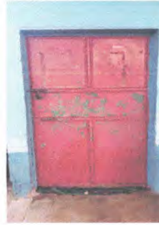
AULAS: MANTENIMIENTO A ESTRUCTURA LIJADO, CEPILLADO, Y APLICACIÓN DE PINTURA A PUERTAS DE METAL
