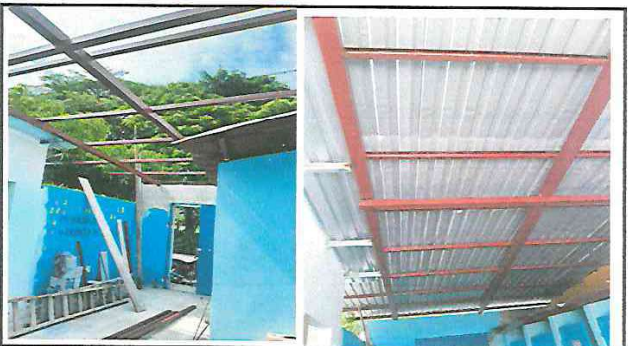
ESTRUCTURA DE METAL FINALIZADA Y SE COLOCA LAMINA RECICLADA.
