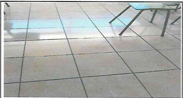
PISO TERMINADO EN AULA 6
