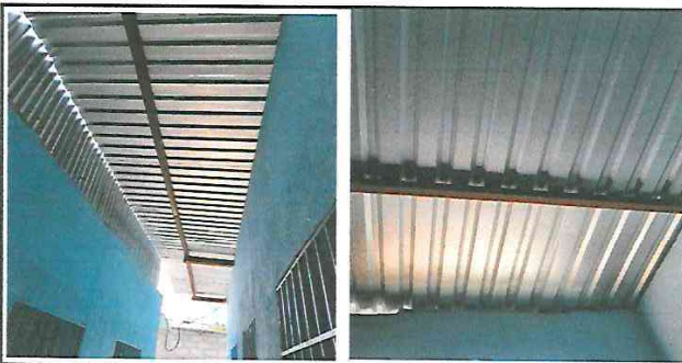
SUSTITUCIÓN DE CUBIERTA DE LÁMINA TERMINADA
