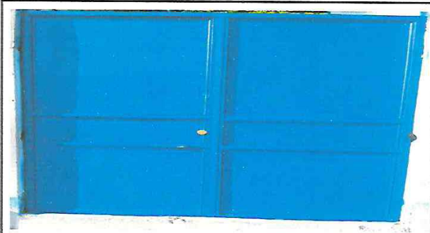
PORTON HACIA LA CANCHA FINALIZADO
