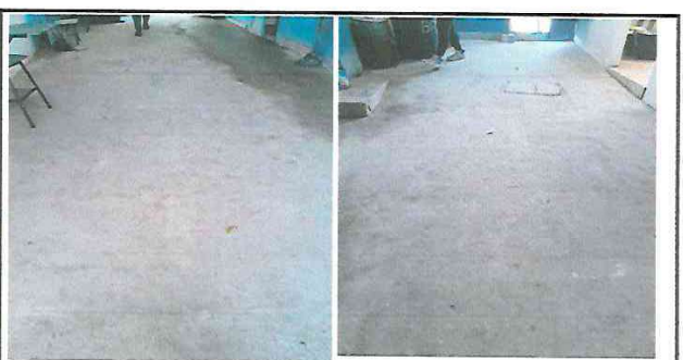
LOSA DE PATIO FINALIZADA.
