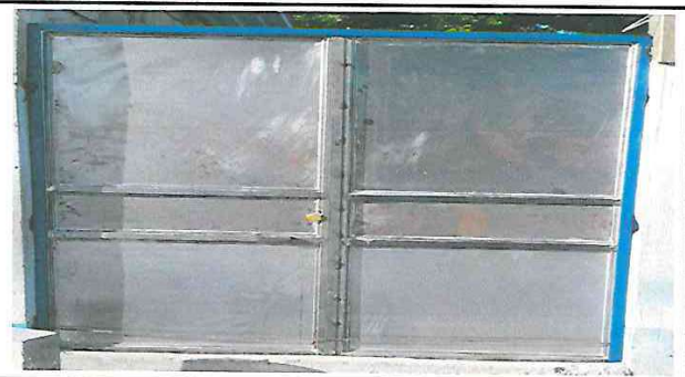
Momento donde se trabaja en el portón de dos hojas que conduce a la cancha.
