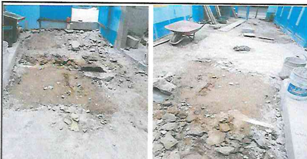
Momento donde se está haciendo las reparaciones en la losa de patio debido a que estaba agrietada y sin desnivel.
