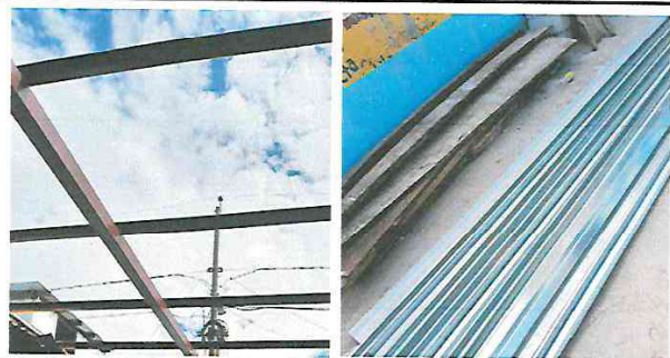
Momento donde se hace sustitución de lámina en mal estado de las aulas 1, 2, 3 y 4.
