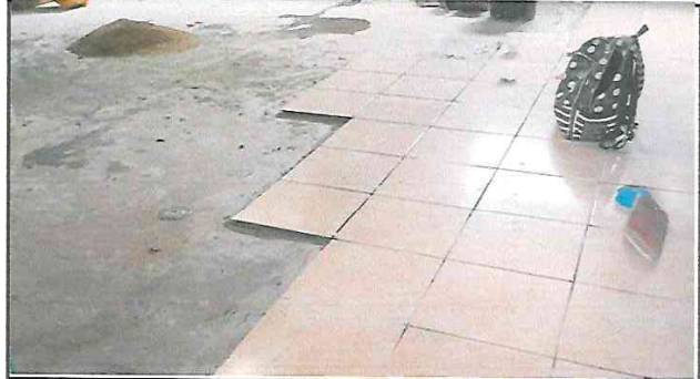
Momento donde se coloca piso cerámico en las aula 6
