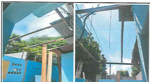
Momento en que se trabaja para el cambio de estructura de mandera por estructura de metal.
