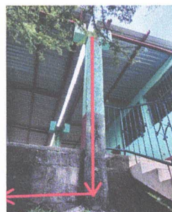
Foto 4: Sustitución de bajada de aula pluvial
