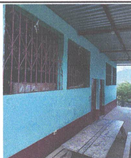
Foto 5: Pintura en muros interiores y exteriores
