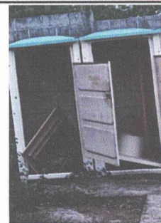
Foto 6: Sustitución de inodoros
