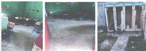
Foto 3: sustitución de piso cerámico aulas y baños
