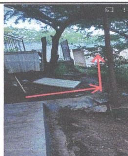
Foto 4: Instalación de tubería principal de pvc
