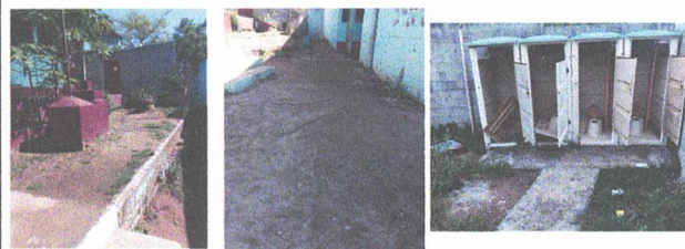
Foto 2: sustitución de piso de torta de concreto
