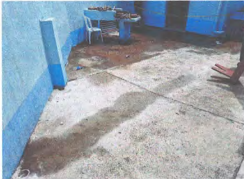
Foto1: Sustrucción de piso de torta de concreto.
