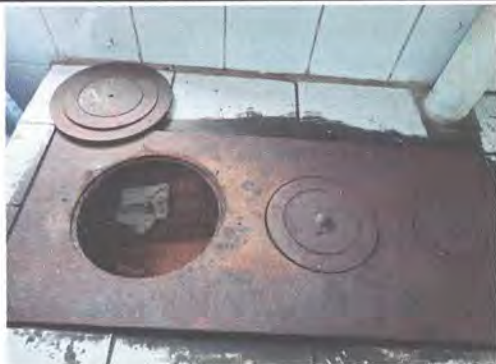
Foto7: Sustrucción de plancha de metal de 3 hornillas.
