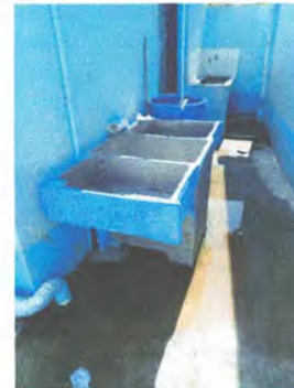
Foto 6: Instalación de pila.
