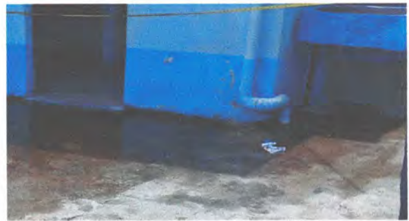
Foto 4: Sustrucción de tubería pvc lineal principal de aguas negras en piso de torta.
