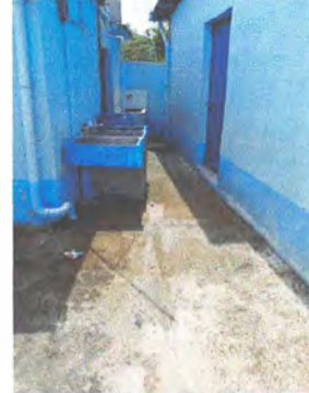
Foto 2: Fabricación e instalación de canal y sus bajadas.
