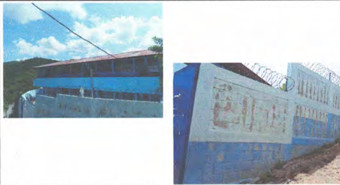
Foto 3: Pintura en muros exterior e interiores.
