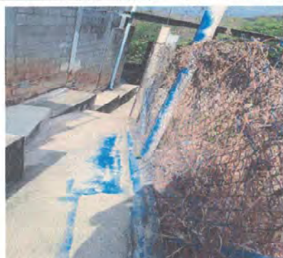
Foto 3: Reparación de muro perimetral que por la lluvia se cayó.
