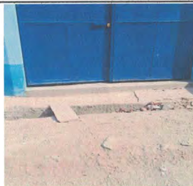
Foto 4: Reparación de la cuneta es para evitar acumulación de basura tierra porque en invierno se estanca el agua.
