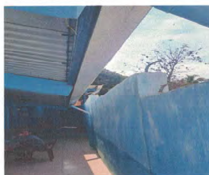
Foto 6: Reparación de techo por filtraciones de agua.
