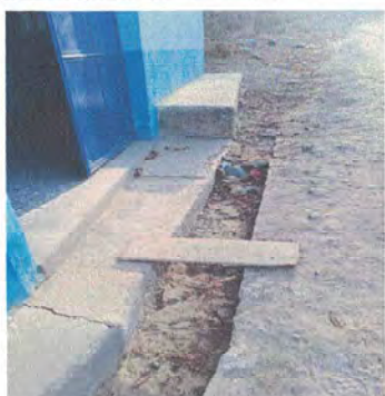
Foto 3: Reparación de cuneta de concreto.
