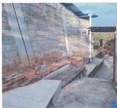
Foto 3: Repello de muro.
