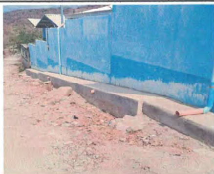
Foto 5: Reparación de banqueta de concreto, por daños ocasionados por la lluvia.
