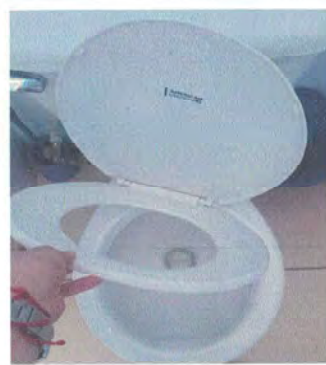
Foto 2: Sustitución de tapadera de sanitario.
