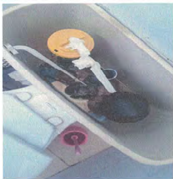
Foto 1: Cambio de accesorios de inodoros.
