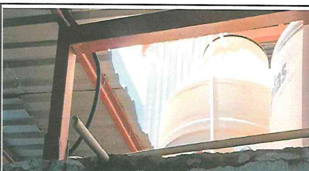
SUSTITUCIÓN DE DEPÓSITO DE AGUA TERMINADO
