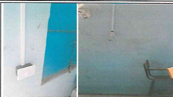
SISTEMA ELECTRICO REPARADO CON TOMACORRIENTES NUEVOS EN TODOS LOS SALONES TERMINADO.
