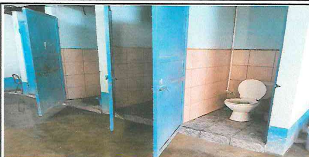
SERVICIO DE AGUA EN BAÑOS REPARADO Y EL MANTENIMIENTO
