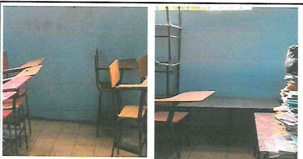
CERNIDO Y REPELLO EN AULA TERMINADO
