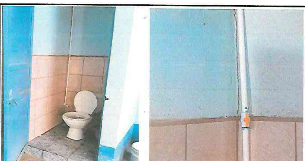
TUBERÍA PVC PARA AGUAS SERVICAS QUE CONDUCE A LA FOSA TERMINADA Y BAÑOS TERMINADOS.
