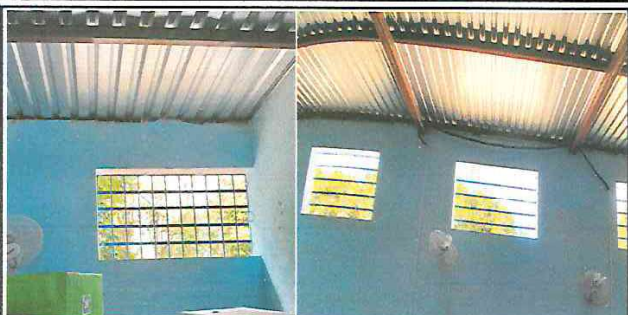
VENTANAS AMPLIAS Y BALCONES INSTALADOS Y TERMINADOS
