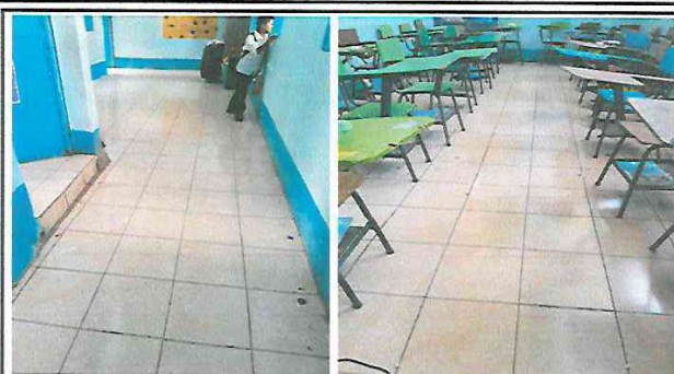
PISO EN AULAS Y PASILLO FINALIZADO
