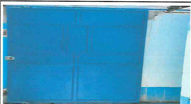
SUSTITUCIÓN DE PORTÓN DE MALLA POR UNO DE METAL TERMINADO.
