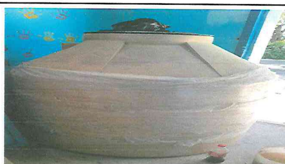
SUSTITUCION DE DEPÓSITO DE AGUA
