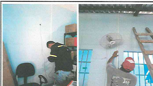
MOMENTO EN QUE SE TRABAJA EL SISTEMA ELÉCTRICO
