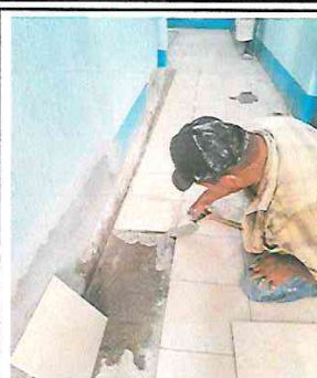
MOMENTO DONDE SE COLOCA PISO CERÁMICO EN AULAS Y PASILLO
