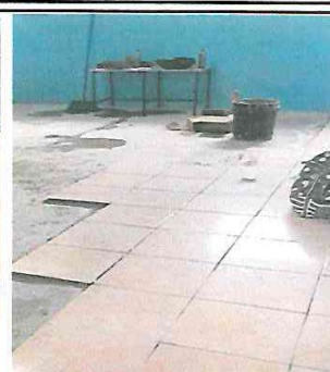
MOMENTO DONDE SE COLOCA PISO CERÁMICO EN AULAS Y PASILLO
