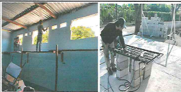
MOMENTO EN QUE SE TRABAJA EN LOS BALCONES NUEVOS
