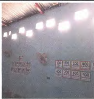
Foto 7: Elaboración de balcones para sustituir por unos de mayor tamaño para lograr la iluminación en las aulas 1, 2, 3 y 4.
