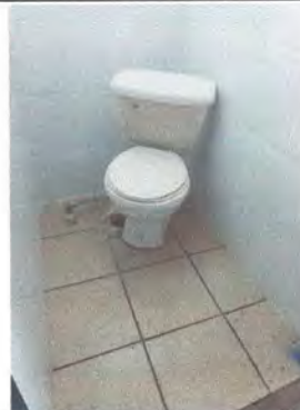
Foto 4: Sustitucion de accesorios inodoro.
