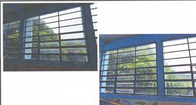
Foto 2: Sustitucion de estructura de metal de ventanas.
