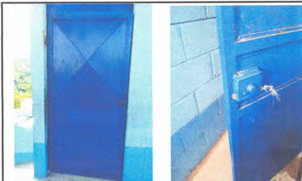
Foto1: Mantenimiento a estructura 1.00 X 2.15M (Lijado, cambio de tubo, sujetosiones).
