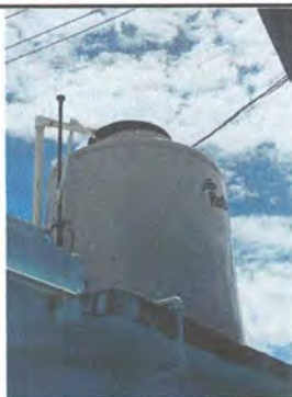
Foto 5: Sustitucion de deposito de agua 1,100 litros, sustitucion de accesorios deposito de agua.
