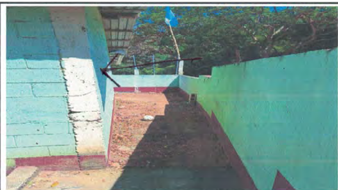
Foto 3: AULA PREPRIMARIA DONDE SE INSTALARA VENTANA.
