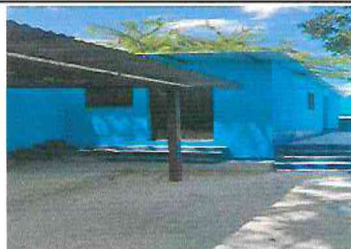
Foto 2: Reparación de Cocina. (Sustitución para leña, capana metálica para hornillas de leña, repisas de concreto para cocina, tabiques de block, reubicar acceso a cocina, reubicar puerta y ventana y pintura a paredes de Cocina).
