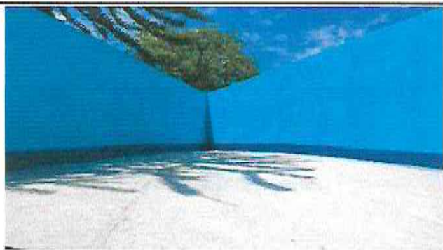
Foto 3: Reparación de Muro perimetral. (Repello, cernido y aplicación de pintura en interiores y exteriores; y rotulo de escuela).
