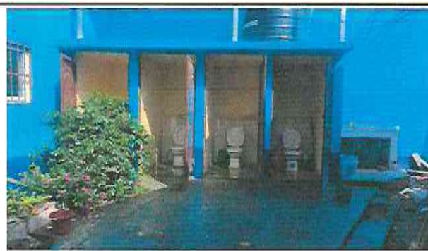
Foto 4: Reparación de Servicios Sanitarios.
