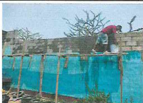
Foto 3: Reparación de Muro perimetral. (Repello, cernido y aplicación de pintura en interiores y exteriores; y rotulo de escuela).
