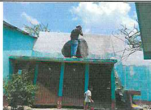
Foto 4: Reparación de Servicios Sanitarios.
