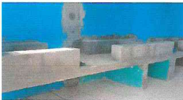
Foto1: Reparación de Cocina. (Sustitución de hornillas para leña, campana metalica para hornillas de leña, repisas de concreto para cocina, tabiques de block y pintura a paredes de cocina).
