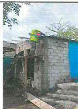
Foto 2: Reparación de Cocina. (Sustitución para leña, capana metalica para hornillas de leña, repisas de cocconreto para cocina, tabiques de block, reubicar acceso a cocina, reubicar puerta y ventana y pintura a paredes de Cocina).
