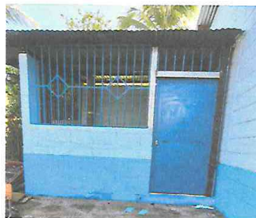
Foto 4: Pintura, colocación de ventana y puerta en cocina.
