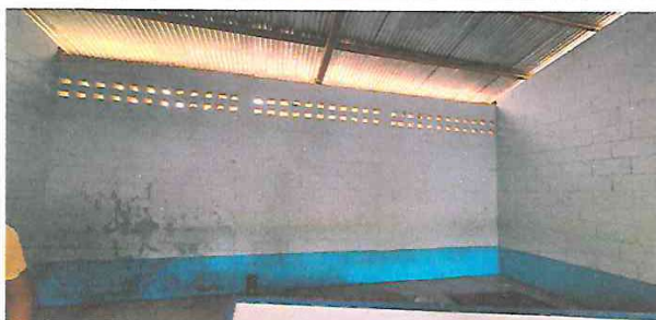
Foto 1: Pintura en muros interior
