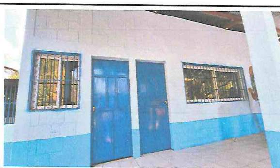
Foto 6: Pintura en muros exterior, puertas, balcones y piso cerámico.
