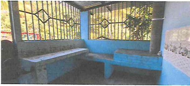
Foto 7: Mueble de concreto en cocina.
