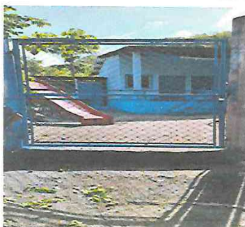
Foto 3: Instalación y pintura de puerta de entrada No. 1
