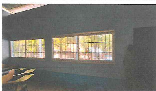
Foto 2: Colocación de ventanas pvc en aula
