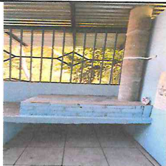
Foto 5: Instalación de estufa rural.
