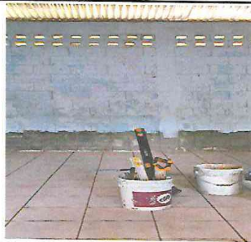
Foto 11: Pintura de muro interior en aula
