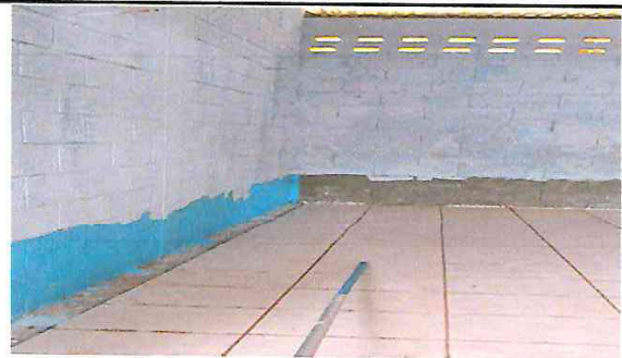
Foto 5: Pintura de muros interior en aula
