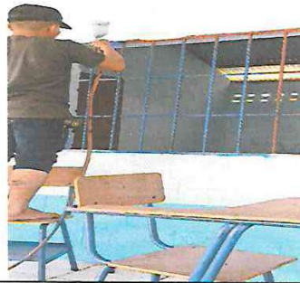
Foto 2: Pintura de balcones de aula.
