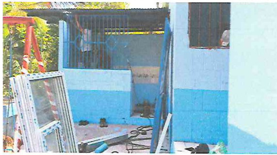
Foto 1: Colocación de balcones en cocina.
