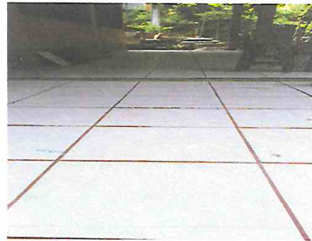
Foto 4: Colocación de piso cerámico en corredor.
