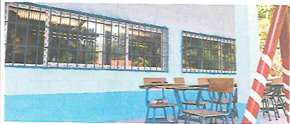
Foto 12: colocación de ventana pvc en aula.
