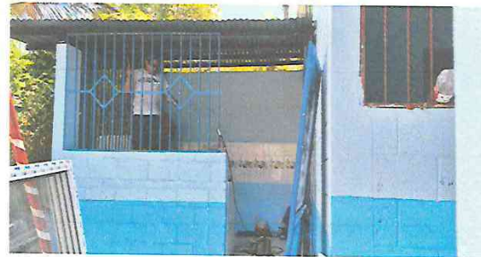
Foto 10: Colocación de balcón en cocina
