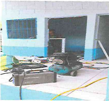
Foto 7: Colocación de ventana pvc en dirección
