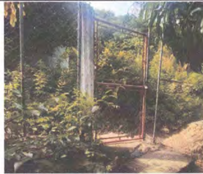
Foto 12: Muro Perimetral: Sustitución de Puerta de Emergencia Con Tubo Cuadrado de 1 1/2" Chapa 14 y Malla Galvanizada de Rombo de 2" Calibre 12. Para Escuela Primaria.
