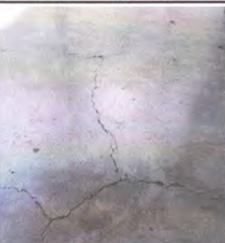
Foto 5: Reparación de Piso, Sustitución de piso de concreto por piso ceramico, en area de DIRECCIÓN Y BODEGA, Parte Interna y Aplicación de Pintura Latex en Paredes. Escuela Primaria.
