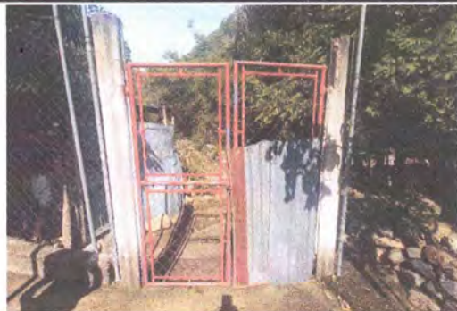
Foto 11: Muro Perimetral: Sustitución de Portón de Acceso Con Tubo Cuadrado de 1 1/2" Chapa 14 y Malla Galvanizada de Rombo de 2" Calibre 12. Para Escuela Primaria.
