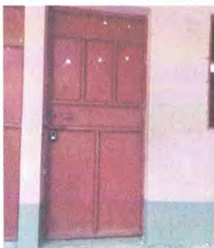
Foto 1: Mantenimiento a Puertas Metálicas. (Desmontarse, Cortarse, Reinstalarse, Lijar y Aplicar 2 Manos de Pintura R15 secado rapido, para Escuela Primaria.
