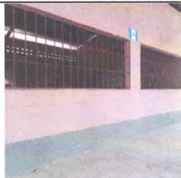
Foto 2: Mantenimiento Balcones Metálicos, Sustitución e Instalación de Ventanas Marcos de PVC. Con Vidrio de 5mm. Y Aplicación de Pintura Latex en AULA PURA, Escuela Primaria.
