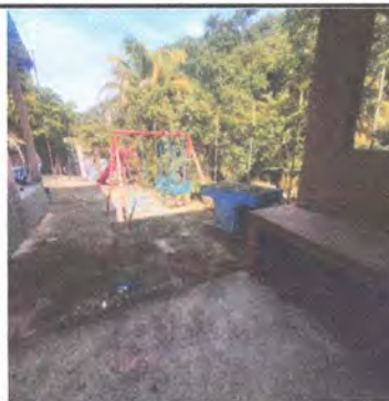
Foto 10: Rehabilitación de Area para Cocina, Sustitución de Piso de Torta por Piso Ceramico IP-IV, Sustitución e Instalación Balcón Metálico, Cerramiento o Tabique de Muro de Block, Aplicación de Pintura R15, Aplicación Pintura Latex e Instalación de Puerta Metálica; Escuela Primaria.
