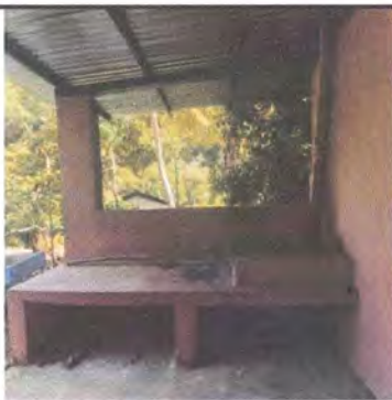
Foto 9: Rehabilitación de Area para Cocina, Sustitución de Piso de Torta por Piso Ceramico IP-IV, Sustitución e Instalación Balcón Metálico, Cerramiento o Tabique de Muro de Block, Aplicación de Pintura R15, Aplicación Pintura Latex e Instalación de Puerta Metálica; Escuela Primaria.
