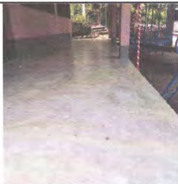
Foto 7: Reparación de Piso, Sustitución de piso de concreto por piso ceramico, en area de CORREDOR, Parte Externa y Aplicación de Pintura Latex en Paredes. Escuela Primaria.
