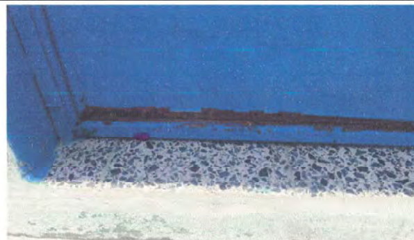
Foto 4: Sustrucción de puertas en servicios sanitarios.
