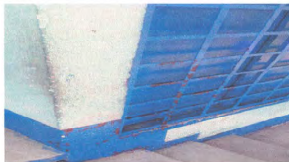
Foto 6: Mantenimiento de estructuras de metal en ventanas que se encuentran en mal estado.
