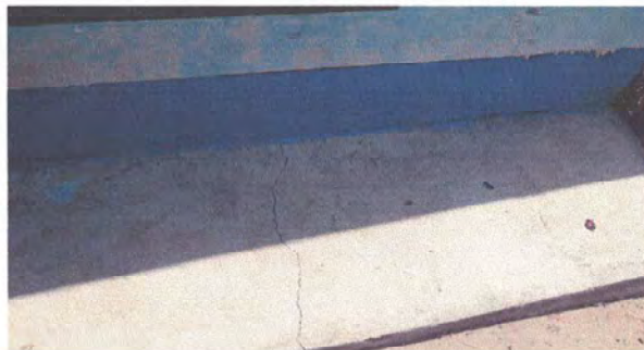
Foto 18: Reparación de concreto de patio que se encuentra agrietado.
