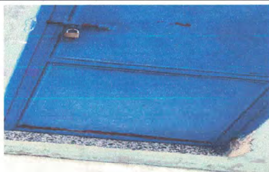
Foto 3: Sustrucción de puerta en servicios sanitarios
