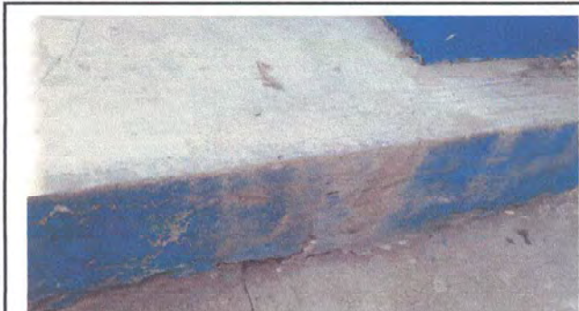
Foto 19: Reparación de concreto de patio que se encuentra en mal estado
