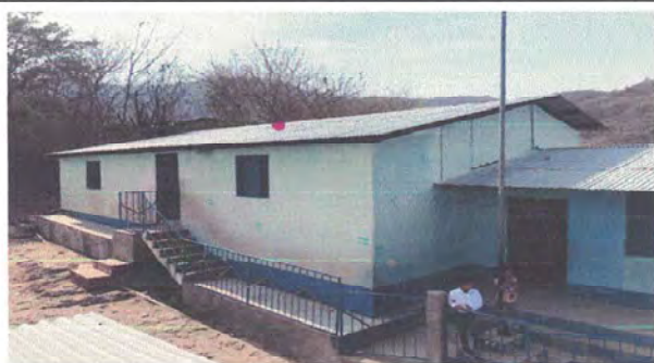
Foto 11: Pintura en muros exteriores se encuentra en mal estado.
