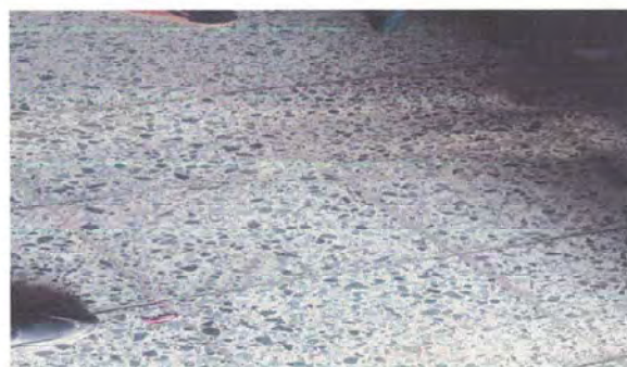
Foto 8: Mantenimiento de piso de granito se va a pulir y lustrar ya que se encuentra muy sucio y opaco.
