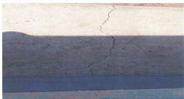
Foto 17: Reparación de concreto de patio que se encuentra agrietado.
