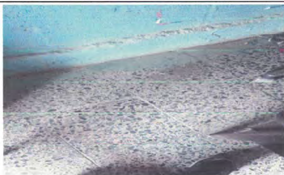
Foto 7: Mantenimiento de piso de granito se va a pulir y lustrar ya que se encuentra muy sucio y opaco.
