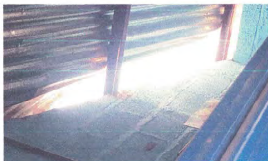
Foto 1: Sustrucción de láminas troqueladas ya que se encuentran en mal estado y con goteras, Mantenimiento de soporte de metal.
