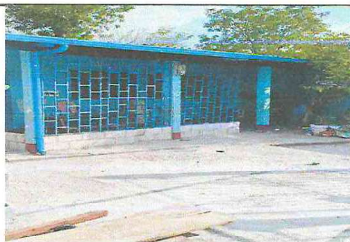
Foto 4: SUSTITUCION DE VALCON
