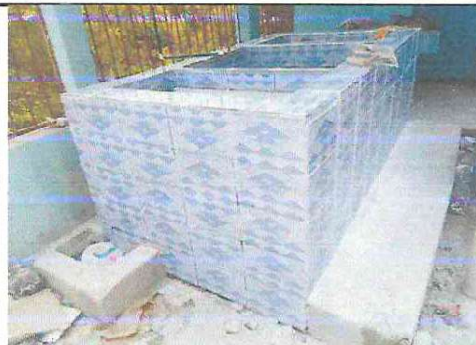
Foto 2: REPARACION DE PILA Y COLOCACION DE AZULEJOS
