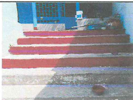
Foto 3: APLICACIÓN DE PINTURA
