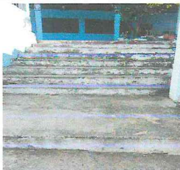
Foto 3: APLICACIÓN DE PINTURA
