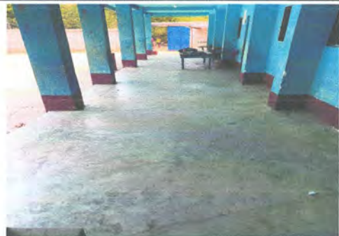
Suministro e instalacion de piso en corredor de 16.5 x 3 mts.
