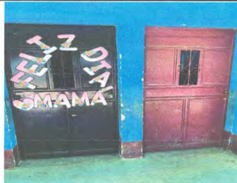
Reparacion de 3 puertas de salones de clases de metal, resanacion y aplicación de pintura
