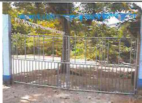
Foto 4: Mantenimiento de estructura (lijado, cambio de tubo, sujeciones, aplicación de pintura).
