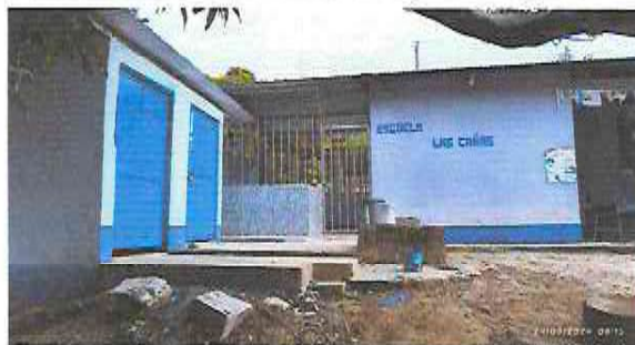
Foto 3: Fundición de piso de torta de concreto.
