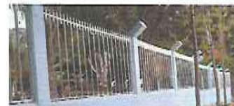
Foto 6: Instalación de baranda de muro perimetral.
