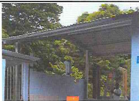
Foto1: Sustrucción de lámina, por lámina aluzinc calibre 26.
