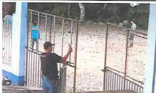
Foto 4: Mantenimiento de estructura (lijado, cambio de tubo, sujeciones, aplicación de pintura).
