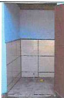
Foto 5: Sustitución de inodoro, instalación azulejo.
