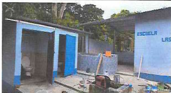
Foto 3: Fundición de piso de torta de concreto.
