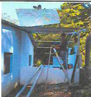
Foto 1: Sustitución de lámina, por lámina aluzinc calibre 26.
