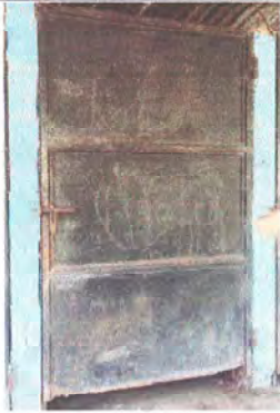
Foto 1: Sustrucción de puertas para sanitario
