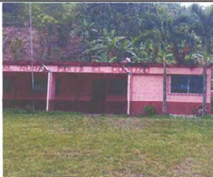
Foto 7: Sustitución de pintura de escuela
