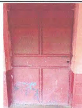
Foto 4: Sustrucción de puertas de aulas
