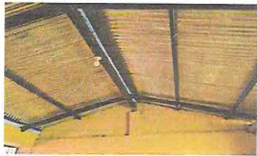
Foto 20: CERRAMIENTO DE CUMBRERA CON MURO DE BLOCK DEL AULA
