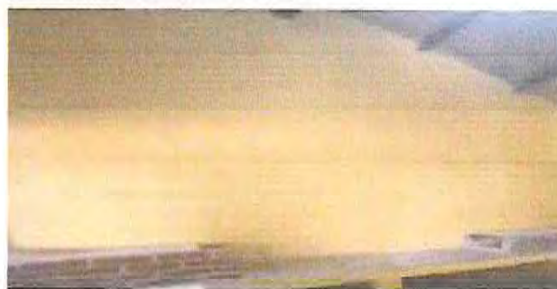
Foto 4: RESANADO DE PARED DE COCINA TERMINADO
