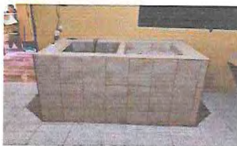
Foto 12: PILA DE LA COCINA TERMINADA
