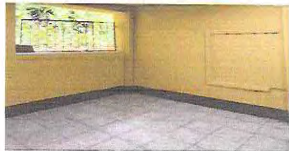
Foto 22: DURANTE COLOCACIÓN DE PISO DE AULA TERMINADO
