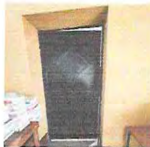
Foto 26: INSTALACIÓN DE PUERTA DEL AULA TERMINADA
