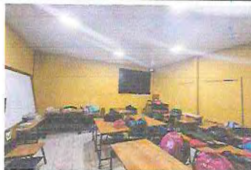
Foto 30: DURANTE PINTURA DEL AULA
