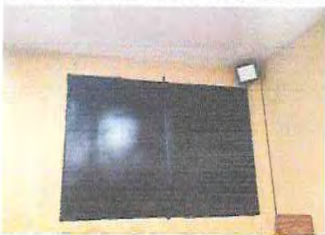
Foto 27: DURANTE COLOCACIÓN DE 3 LÁMPARAS SOLARES 1 EN AULA Y 2 EN CORREDOR
