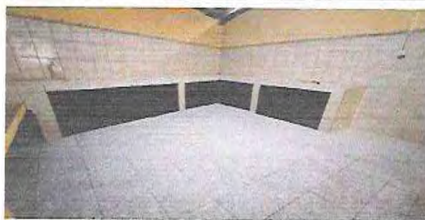
Foto 8: PISO DE LA COCINA TERMINADA
