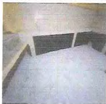
Foto 7: PISO DE LA COCINA TERMINADA
