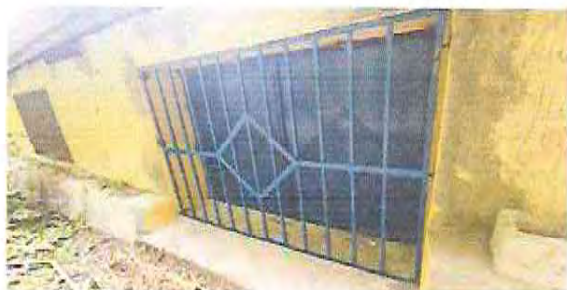
Foto 17: CONSTRUCCIÓN DE VENTANA DEL AULA TERMINADA
