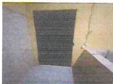
Foto 16: PUERTA DE LA COCINA TERMINADA
