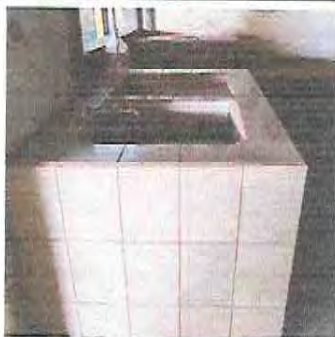
Foto 11: PILA DE LA COCINA TERMINADA
