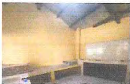
Foto 13: PINTURA DE LA COCINA TERMINADA
