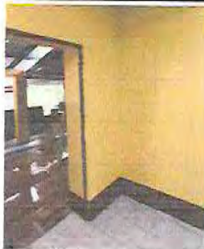
Foto 25: INSTALACIÓN DE PUERTA DEL AULA TERMINADA
