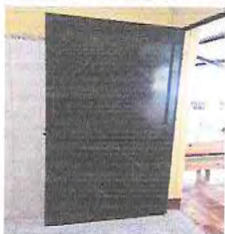
Foto 15: PUERTA DE LA COCINA TERMINADA
