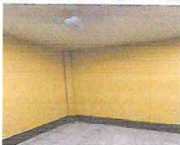
Foto 29: DURANTE PINTURA DEL AULA
