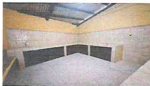
Foto 14: PINTURA DE LA COCINA TERMINADA
