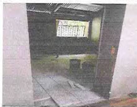
Foto 22: DURANTE COLOCACION DE PISO DE AULA
