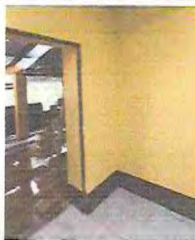
Foto 26 DURANTE INSTACION DE PUERTA DEL AULA
