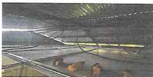
Foto 23: DURANTE INSTALACION CIELO FALSO, VENTILADORES Y LAMPARAS DEL AULA
