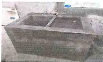
Foto 11: DURANTE CONSTRUCCION PILA DE COCINA
