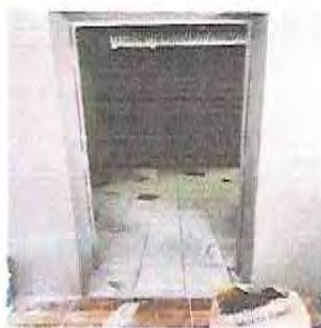
Foto 25: DURANTE INSTACION DE PUERTA DEL AULA
