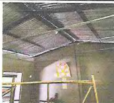
Foto 24: DURANTE INSTALACION CIELO FALSO, VENTILADORES Y LAMPARAS DEL AULA
