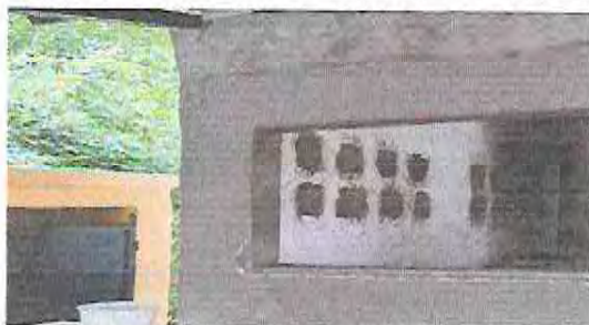
Foto 27: DURANTE COLOCACION DE 3 LAMPARAS SOLARES 1 EN AULA Y 2 EN CORREDOR
