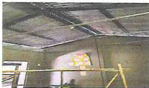
Foto 29: DURANTE PINTURA DEL AULA
