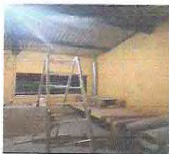
Foto 13: PINTURA DE LA COCINA DURANTE
