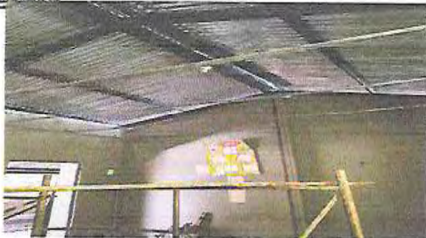
Foto 19: DURANTE CERRAMIENTO DE CUMBRERA CON MURO DE BLOCK DEL AULA
