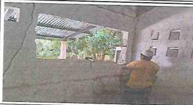
Foto 1: DURANTE LA CONSTRUCCION DE LA VENTANA DE LA COCINA
