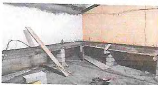
Foto 5: DURANTE CONSTRUCCION GABINETE DE COCINA
