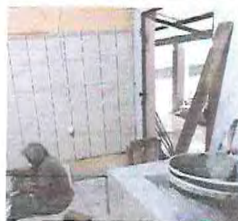
Foto 16: DURANTE PUERTA DE LA COCINA
