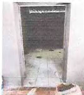
Foto 15: DURANTE PUERTA DE LA COCINA
