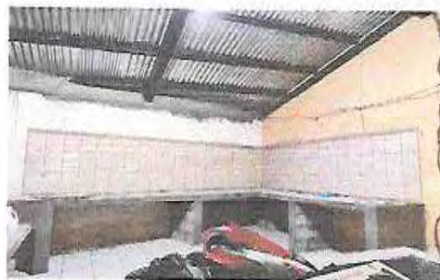
Foto 14: PINTURA DE LA COCINA DURANTE
