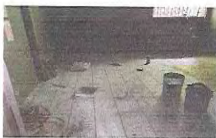
Foto 21: DURANTE COLOCACION DE PISO DE AULA
