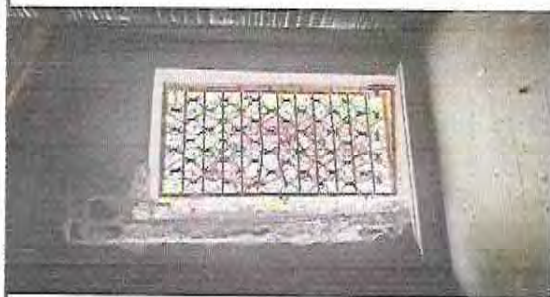
Foto 17: DURANTE CONSTRUCCION DE VENTANA DEL AULA
