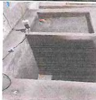
Foto 12: DURANTE CONSTRUCCION PILA DE COCINA
