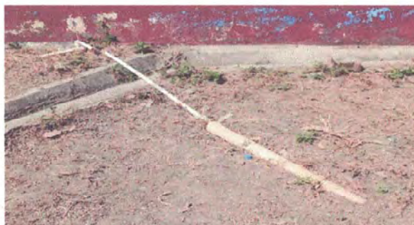
sustitucion de tuberia lineal principal
