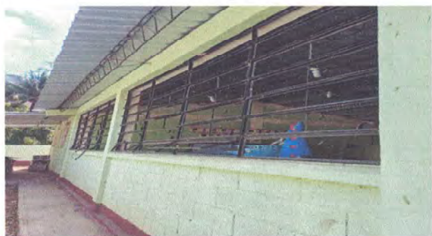
sustitucion de vidrios
