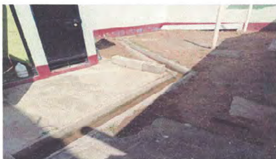
sustitucion piso de torta de concreto
