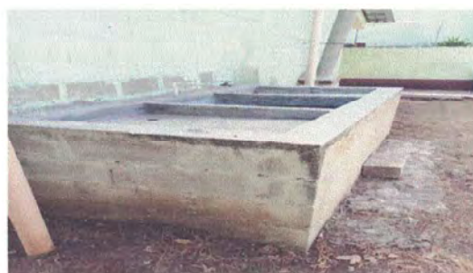
Reparacion de sisterna de concreto
