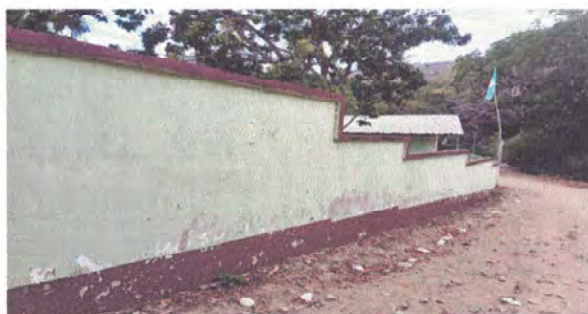
pintura en muros exterior e interior
