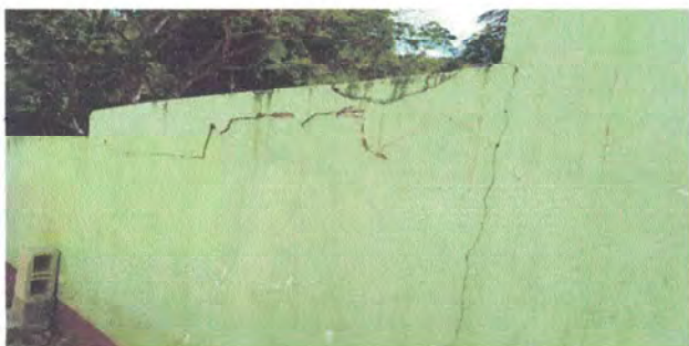
Repacion de muro perimetral
