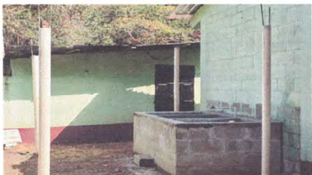
instalacion de estructura y lamina
