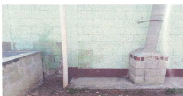
Instalacion de lavamanos
