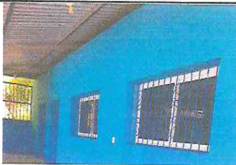
FOTO 15: INSTALACION DE VENTANAS PVC
