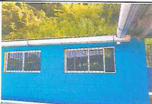
FOTO 17: MANTENIMIENTO DE VENTANA DE METAL
