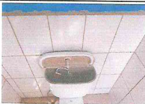
FOTO 9: SUSTITUCIÓN DE ACCESORIOS EN 2 INODOROS
