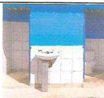
FOTO 10: SUSTITUCIÓN DE ACCESORIOS DE LAVAMANOS
