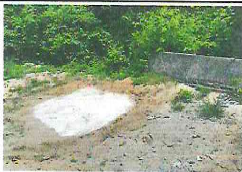
FOTO 1: REPARACION DE FOSA SEPTICA POR HENDIDURA
