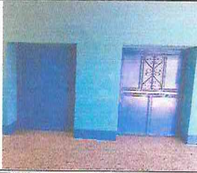
FOTO 13: MANTENIMIENTO EN PUERTA DE METAL
