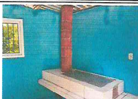
FOTO 2: SUSTITUCION DE PLANCHA DE METAL Y CHIMENEA DE CONCRETO
