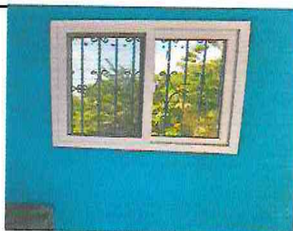
FOTO 5: INSTALACION DE VENTANA PVC
