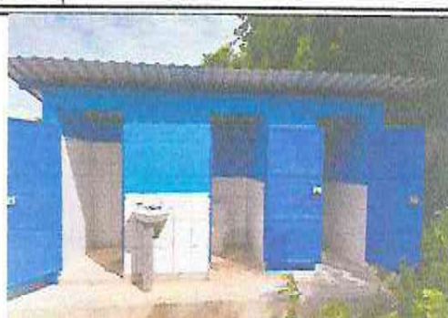
FOTO 8: INSTALACIÓN DE PISO CERAMICO EN EL ÁREA DEL BAÑO
