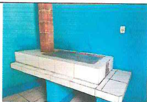
FOTO 3: INSTALACION DE AZULEJO EN ESTUFA RURAL
