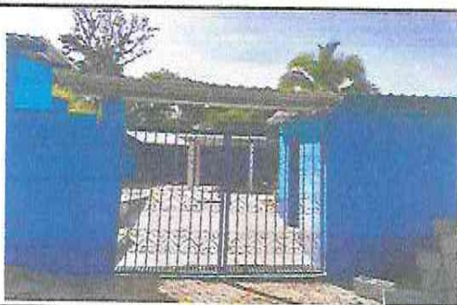
FOTO 11: MANTENIMIENTO DE PORTON
