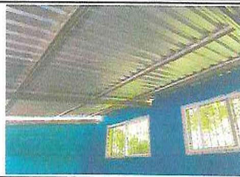
FOTO 14: SUSTITUCION DE LAMINA POR LAMINA TROQUELADA Y SOPORTE DE MADERA POR METAL.
