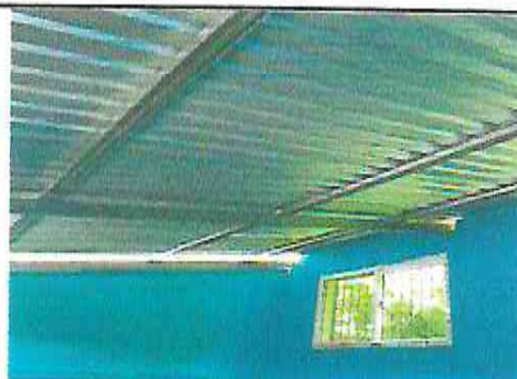
FOTO 4: INSTALACION DE LAMINA Y SUSTITUCION DE SOPORTE DE MADERA POR METAL
