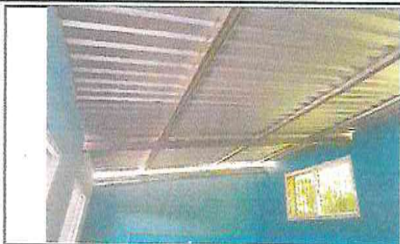
FOTO 7: SUSTITUCIÓN DE LAMINA Y ESTRUCTURA DE SOPORTE DE METAL POR METAL
