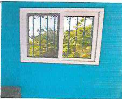
FOTO 5: INSTALACION DE VENTANA PVC
