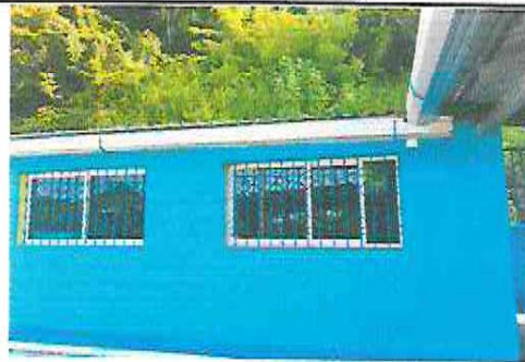
FOTO 16: INSTALACIÓN DE CANAL PLUVIAL, YA QUE DAÑABA LA PARED EN INVIERNO
