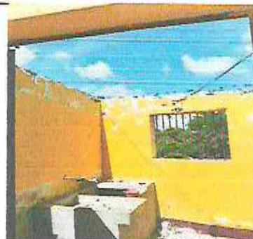
FOTO 4: INSTALACION DE LAMINA Y SUSTITUCION DE SOPORTE DE MADERA POR METAL
