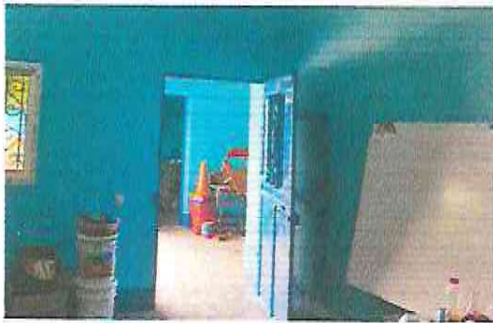
FOTO 13: MANTENIMIENTO EN PUERTA DE METAL
