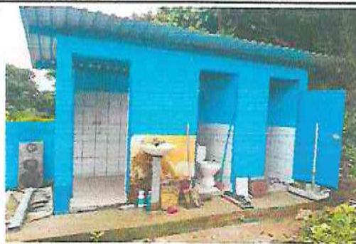
FOTO 8: INSTALACIÓN DE PISO CERAMICO EN EL ÁREA DEL BAÑO
