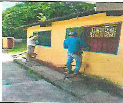
FOTO 17: MANTENIMIENTO DE VENTANA DE METAL
