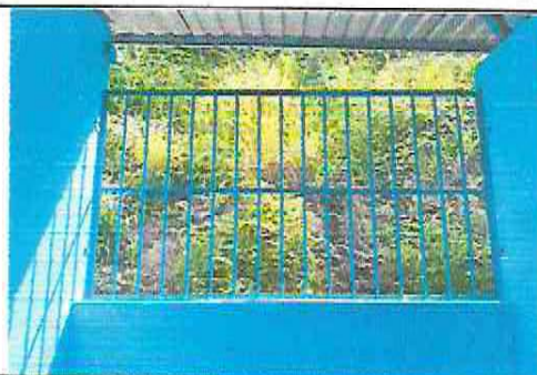
FOTO 12: INSTALACION DE BALCON DE HIERRO
