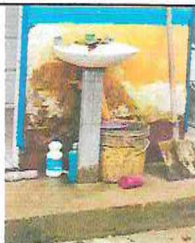
FOTO 10: SUSTITUCIÓN DE ACCESORIOS DE LAVAMANOS
