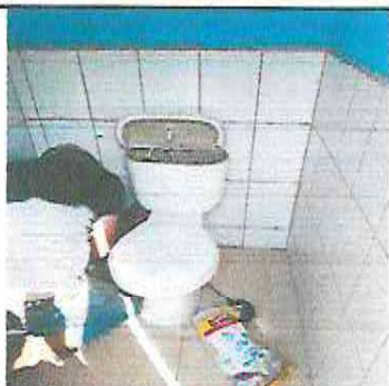
FOTO 9: SUSTITUCIÓN DE ACCESORIOS EN 2 INODOROS
