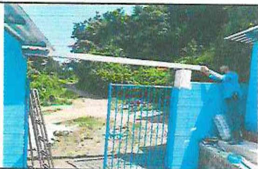
FOTO 11: MANTENIMIENTO DE PORTON
