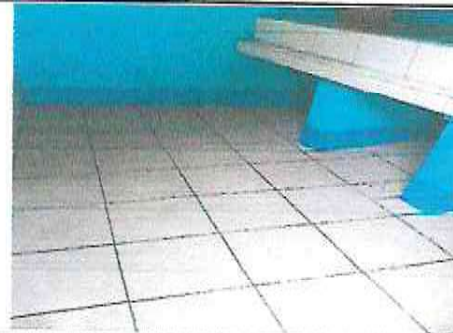
FOTO 6: INSTALACION DE PISO CERAMICO EN EL AREA DE COCINA
