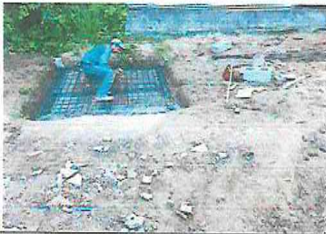
FOTO 1: REPARACION DE FOSA CEPTICA POR HENDIDURA
