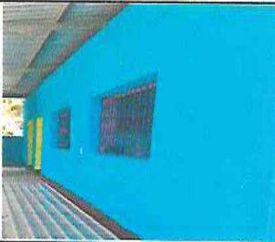
FOTO 15: INSTALACION DE VENTANAS PVC
