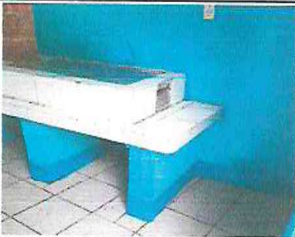
FOTO 3: INSTALACION DE AZULEJO EN ESTUFA RURAL
