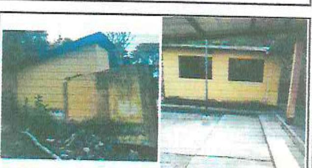
FOTO 18: PINTURA EN INTERIORES Y EXTERIORES.
