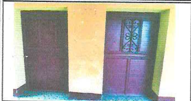
FOTO 13: MANTENIMIENTO DE PUERTA DE METAL
