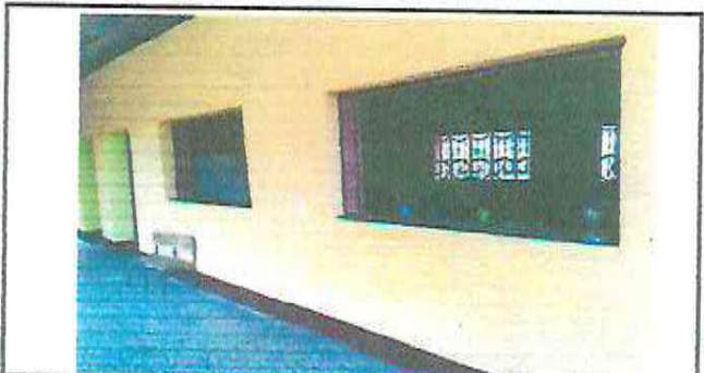
FOTO 15: INSTALACIÓN DE VENTANAS PVC
