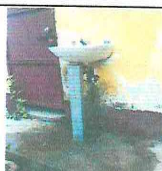
FOTO 10: SUSTITUCIÓN DE ACCESORIOS DE LAVAMANOS
