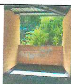
FOTO 12: INSTALACIÓN DE BALCON DE HIERRO
