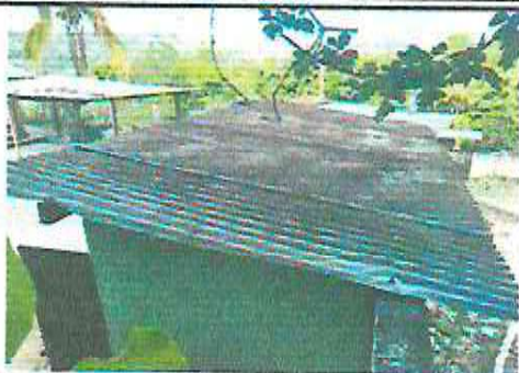
FOTO 7: SUSTITUCIÓN DE LAMINA Y ESTRUCTURA DE SOPORTE DE METAL POR METAL
