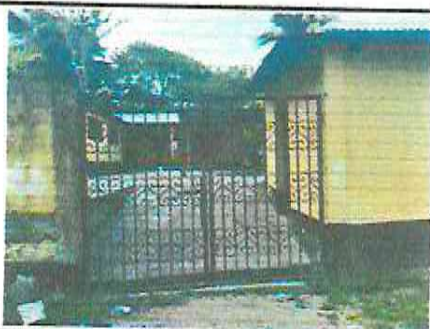
FOTO 11: MANTENIMIENTO DE PORTON
