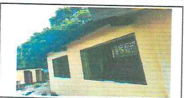
FOTO 17: MANTENIMIENTO DE VENTANA DE METAL
