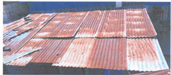
Foto 6: FOTO DE TECHO BAÑO PARTE SUPERIOR
